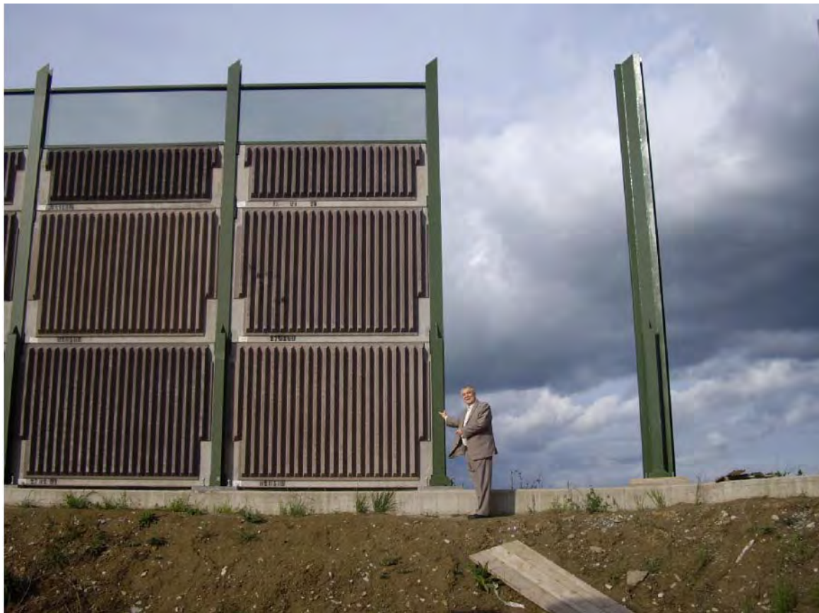
Рисунок 4.4 - Бетонный шумозащитный экран
