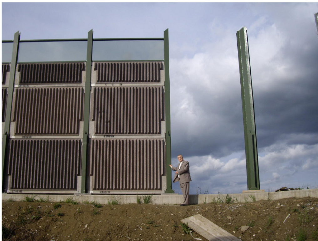
Рисунок 2.5 - Бетонный шумозащитный экран
