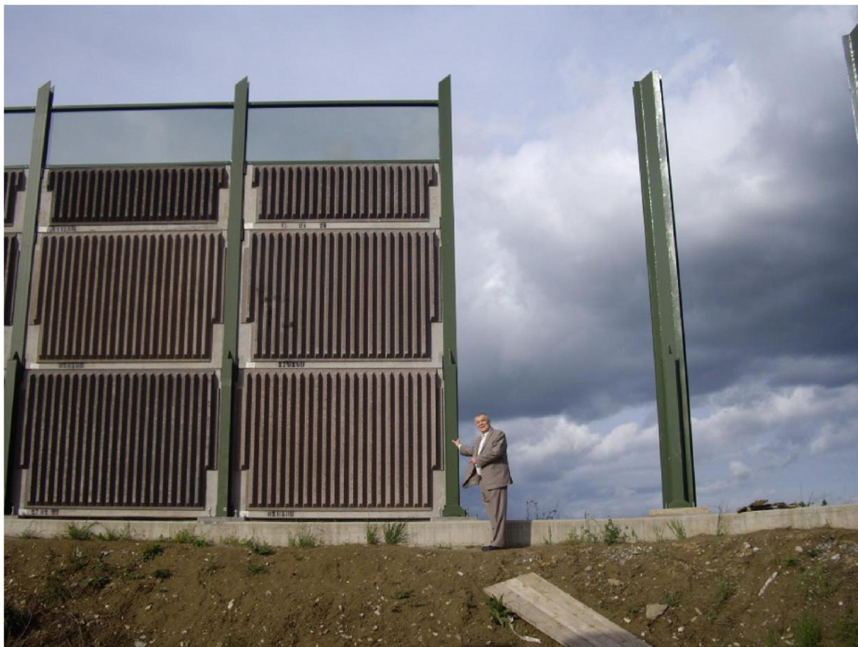
Рисунок 2.5 - Бетонный шумозащитный экран
