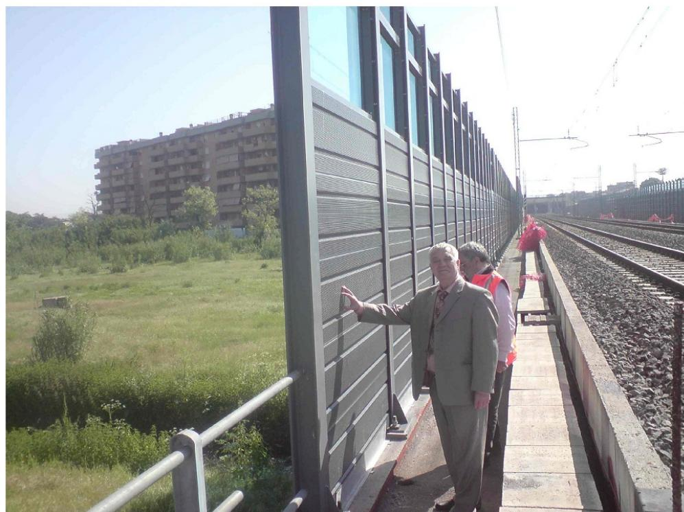
Рисунок 2.6 - Металлический шумозащитный экран
